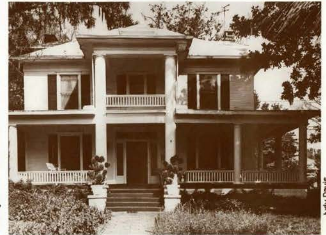
3105 St. Johns Ave. (built 1910)
