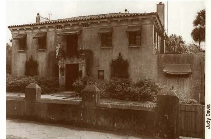
3116 St. Johns Ave. (built 1923)
